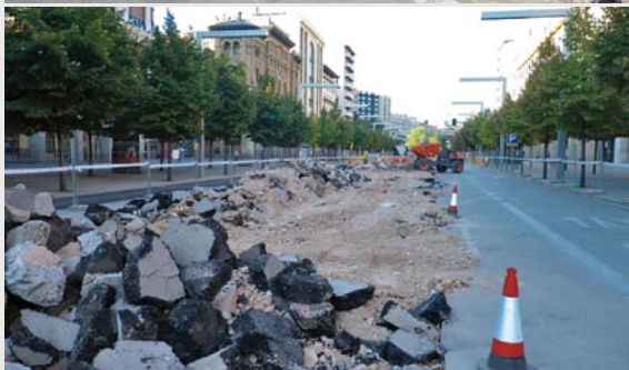
Demolición del pavimento.
