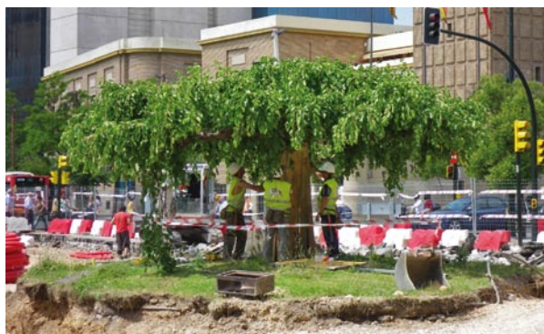
Para evitar daños a las especies vegetales situadas en el entorno más cercano de la obra, se procede a la protección física de estos ejemplares, evitando, en todo caso, la colocación de cuerdas, clavos, cables, cadenas, etc. en los árboles y se realizan labores de cuidado y mantenimiento.
