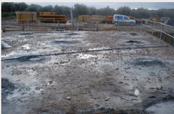
Fotografía que muestra cómo queda dispuesto el polvo de la perforación una vez ejecutados los taladros
