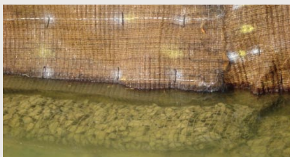
Detalle de los gaviones y la fibra de coco extendida sobre la geomalla.
