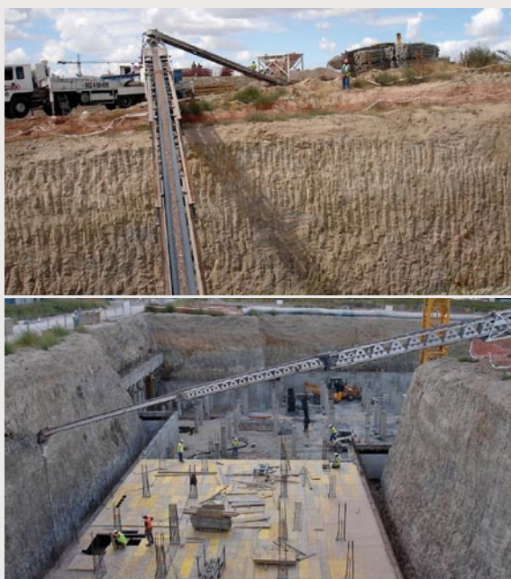
Puesta en obra del material en los sótanos 2 y 3, mediante cinta transportadora alimentada por tolva y acabada en tubería flexible.
