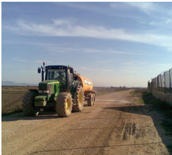
El riego de caminos y acopios es una buena práctica muy fácil de implantar, barata y eficaz para la disminución de las emisiones de polvo, derivadas fundamentalmente de la circulación de maquinaria en la obra.
