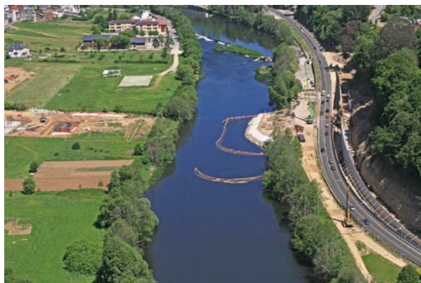
El empleo de pantallas de geotextil es un método muy eficaz para la separación de finos y, por flotación, de los aceites que puede llevar el agua en emulsión, previniendo de este modo la contaminación de las aguas próximas, como en el caso del río Miño que observamos en la imagen.
