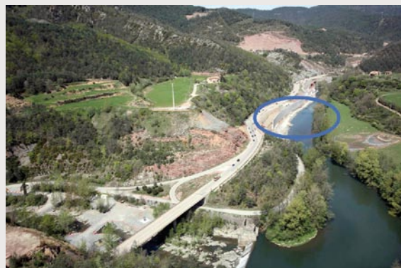
Vista panorámica del muro en construcción y de las balsas de sedimentación en serie construidas en el margen opuesto del río Ter.
