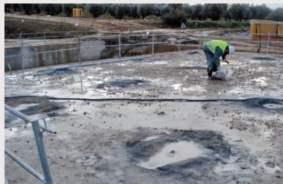
Operario efectuando la recogida del material tras la realización de los taladros
