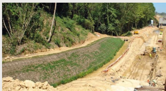
Talud hidrosembrado.
