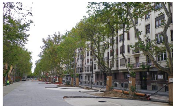
Para evitar daños a las especies vegetales situadas en el entorno más cercano de la obra, se procede a la protección física de estos ejemplares, evitando, en todo caso, la colocación de cuerdas, clavos, cables, cadenas, etc. en los árboles y se realizan labores de cuidado y mantenimiento.
