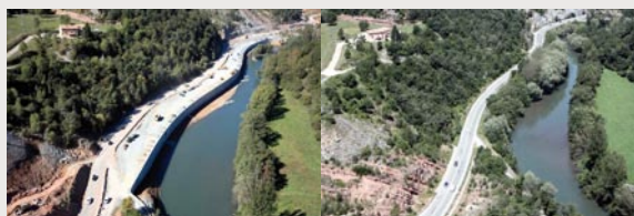
Vistas panorámicas río Ter antes y después de la ejecución del Muro 13.5.
