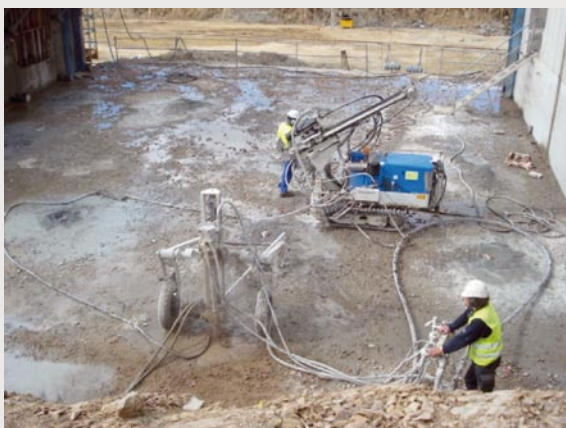
Maquina realizando taladros para inyecciones de consolidación
