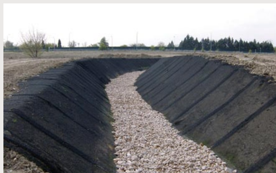
Encauzamiento del arroyo de Rejas, con gravas en el fondo del canal y taludes recubiertos de geomalla hidrosebrada.
