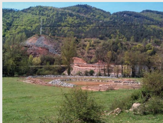
Vista de detalle de las balsas de sedimentación en serie construidas en el margen opuesto del río Ter.
