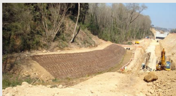
Protección del talud con geomallas.
