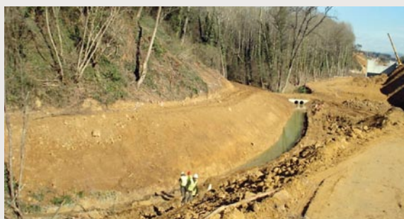
Talud del nuevo encauzamiento.
