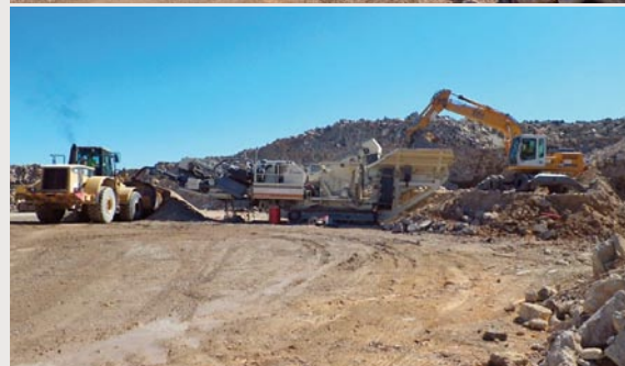
Valorización de RCDs en obra.
