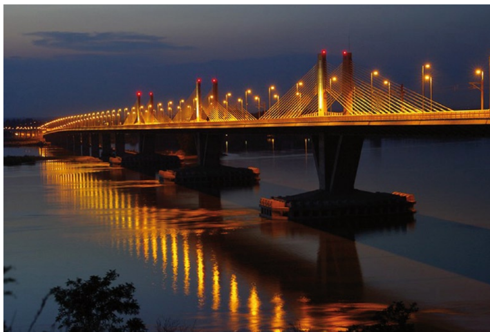
Puente de Vidin, Bulgaria. Mejora de las comunicaciones entre el Sur y el Norte de Europa.
