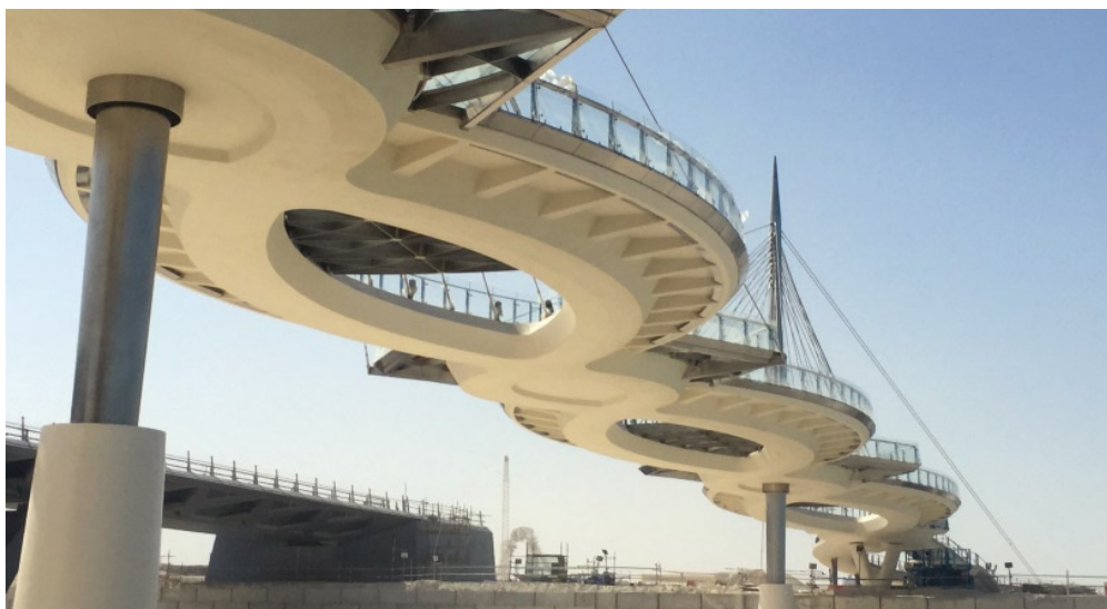
Pasarelas de Lusail, Catar.
