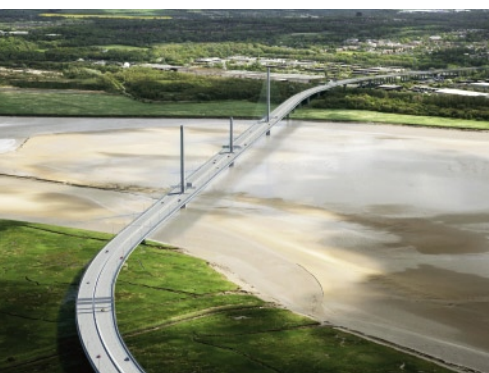
Puente de Mersey, Reino Unido
