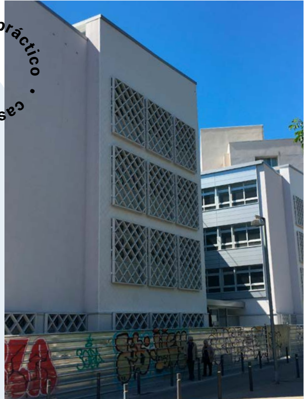
Adaptación de la fachada del edificio para la nidificación de los vencejos durante su paso migratorio en la región.
