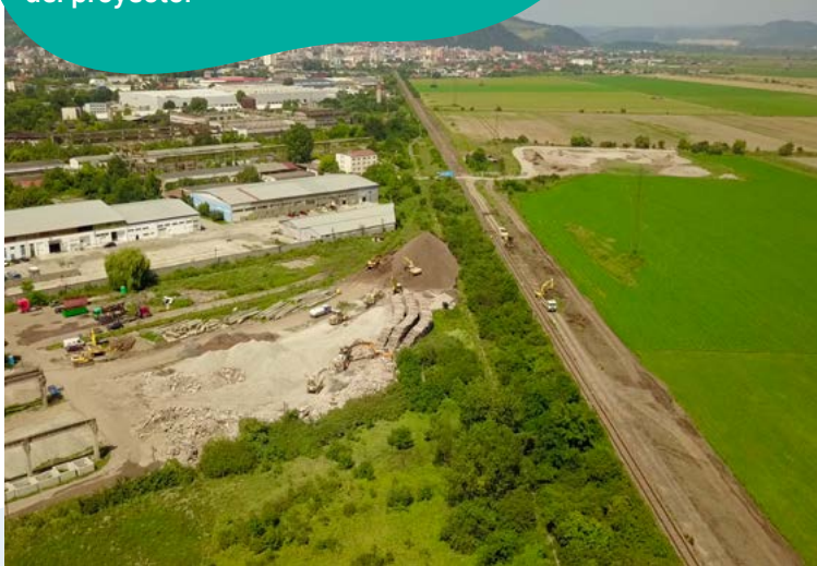
Plataforma para triturar el cemento de la demolición de la superestructura
