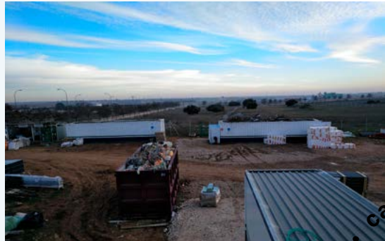
Clasificación y depósito de los residuos valorizados durante la obra
