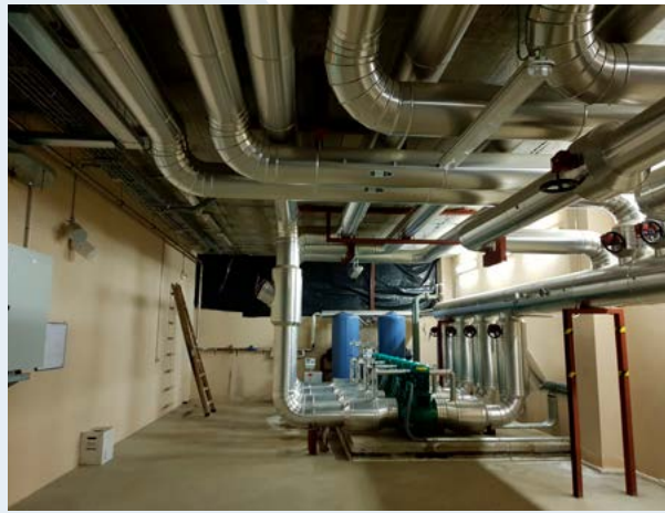
Desvío del saneamiento existente del Hospital de Soria (España).
