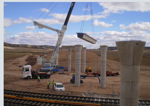
Viaducto Torquemada (Palencia)
