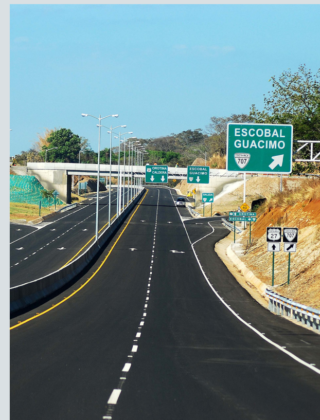
Autopista San José Caldera (Costa Rica)
