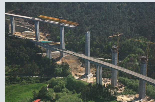
Autovía de Cantábrico. Las Dueñas, Muros de Nalón (Asturias)
