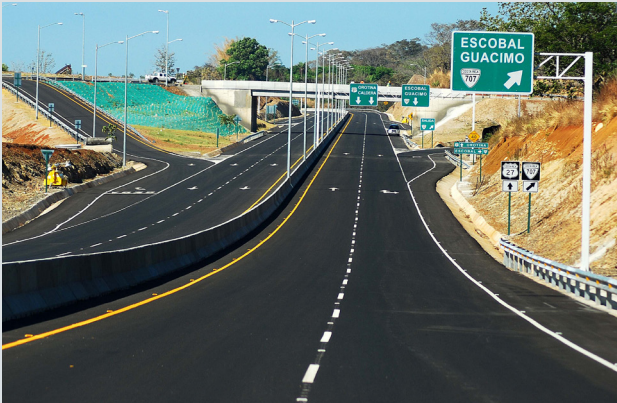
Autopista San José Caldera (Costa Rica)
