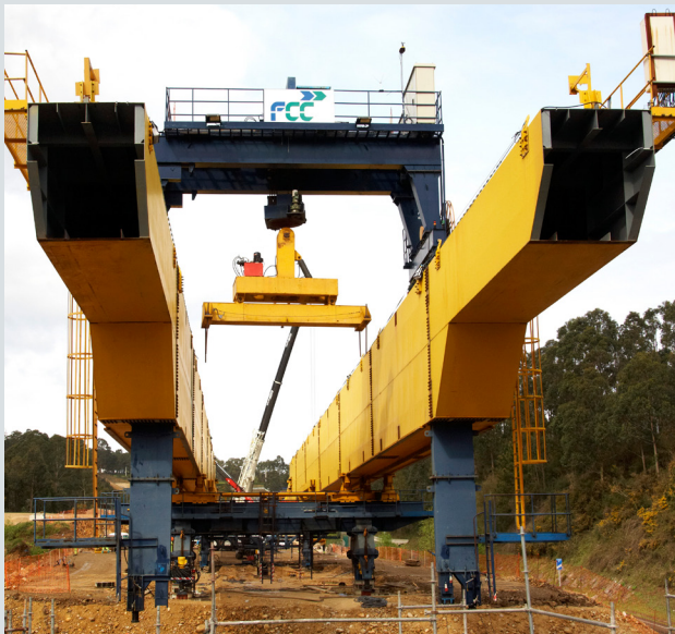
Lanzador de dovelas
