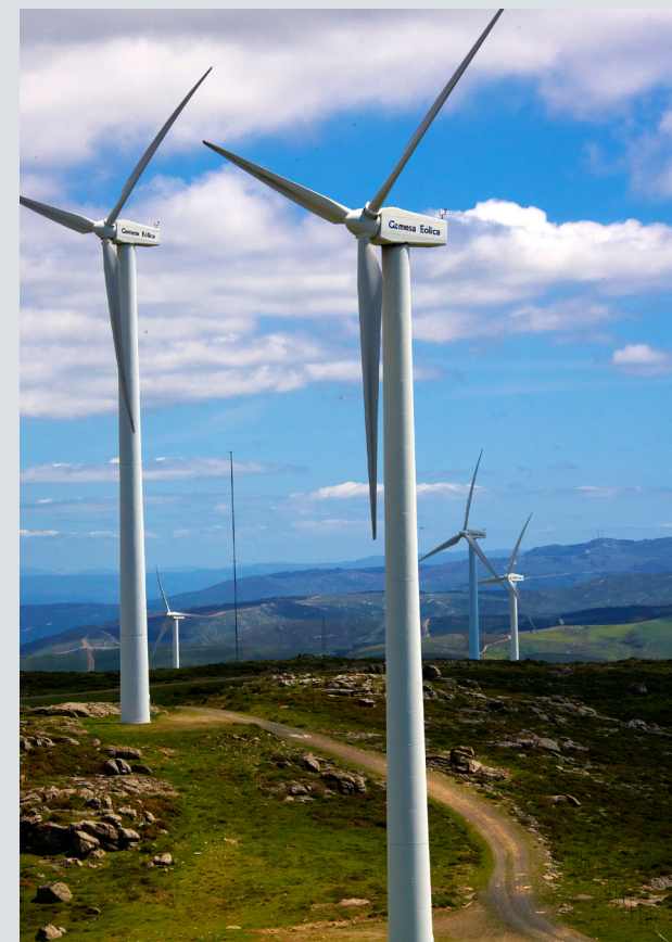
Parque eólico de Seixo y Cando (La Coruña)
