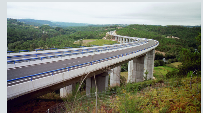
Viaducto sobre el Ulla (autopista gallega)
