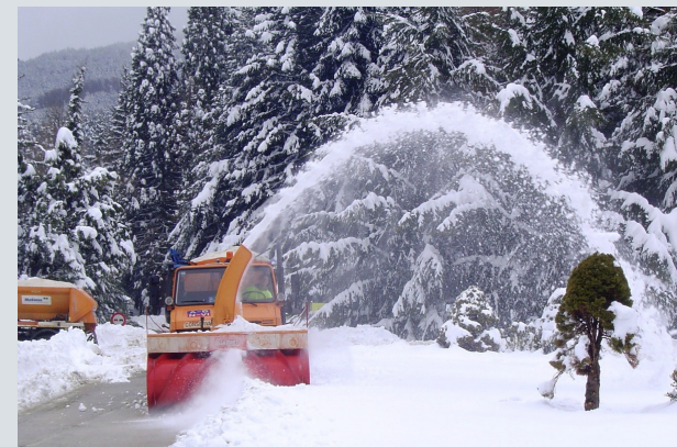
Mantenimiento invernal de carreteras
