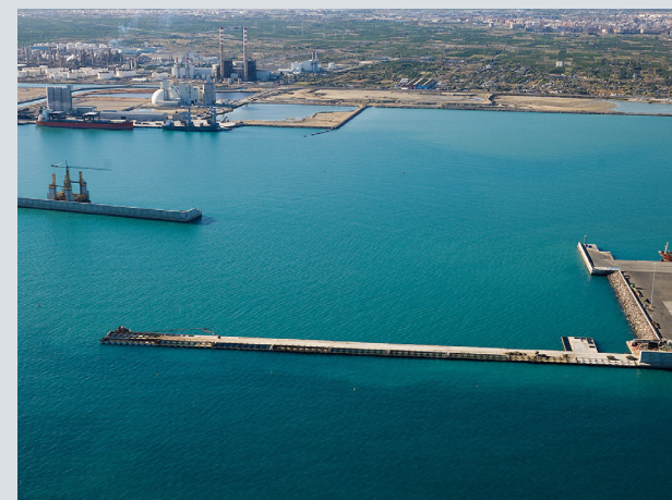
Dique este puerto de Castellón
