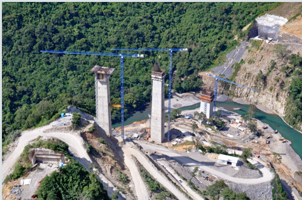
Pilas Viaducto de San Marcos (México)
