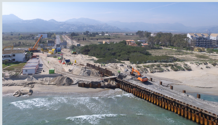
Denia Landfall 3. Gasoducto submarino
