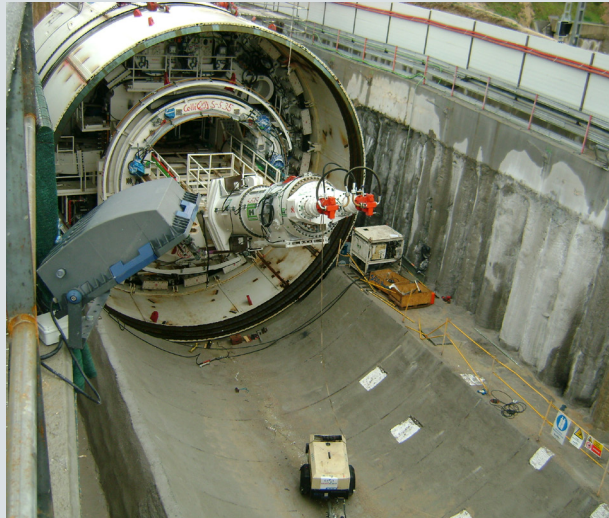
Tuneladora túnel Ave-Atocha-Chamartín (Madrid)
