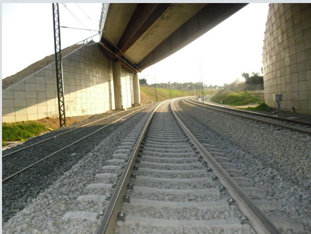
Traviesas monobloque pretensadas
