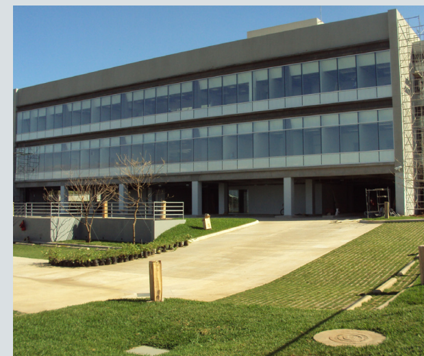
Edificio oficinas BID Nicaragua
