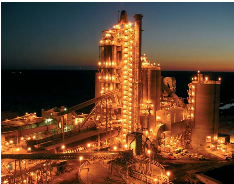
Fábrica de cemento de Harleyville. Carolina del Sur. EE.UU.
