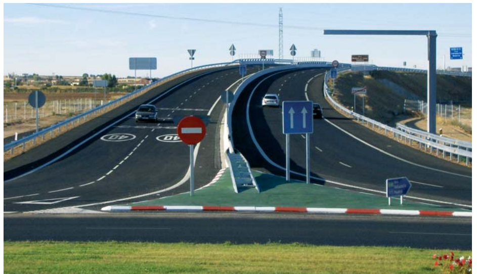
Autovía del Duero. Tramo Toro-Zamora
