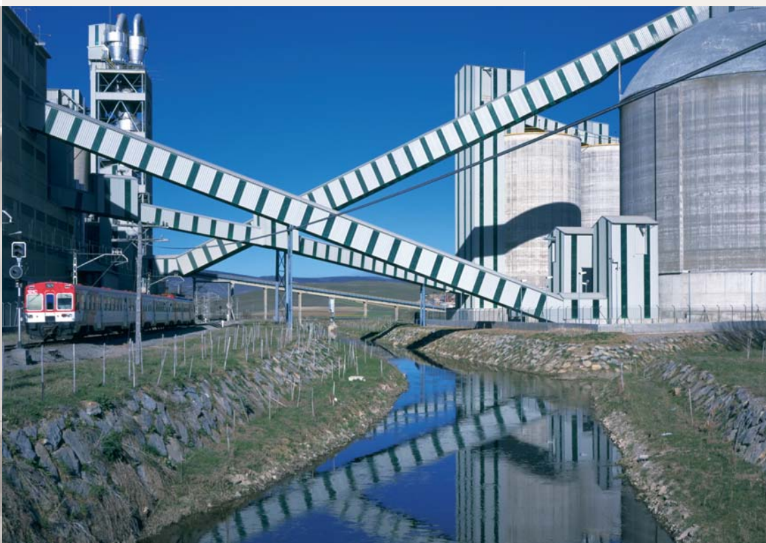
Fábrica de Cementos Alfa en Mataporquera. Cantabria
