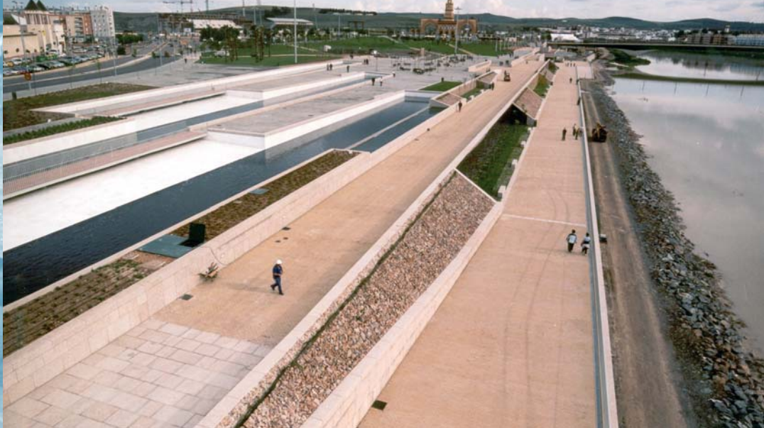
Urbanización El Balcón del Guadalquivir. Córdoba
