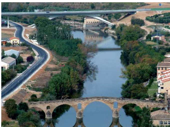
Autovía del Camino. Navarra
