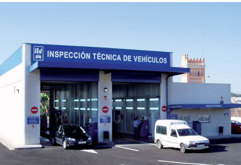
Estación de ITV en Liria. Valencia
