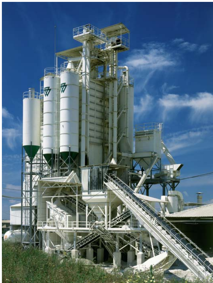
Fábrica de cemento en Alcalá de Guadaíra. Sevilla
