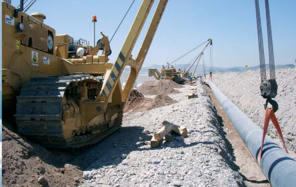
Instalación de un gasoducto de transporte primario en Sagunto. Valencia
