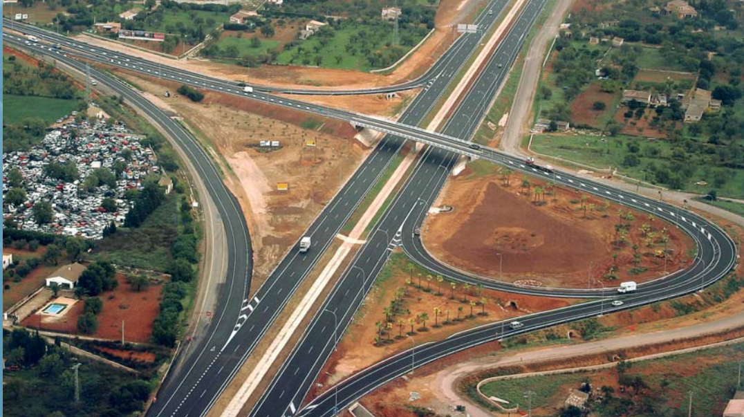
Autopista central PM-27, tramo III. Variante de Inca. Mallorca
