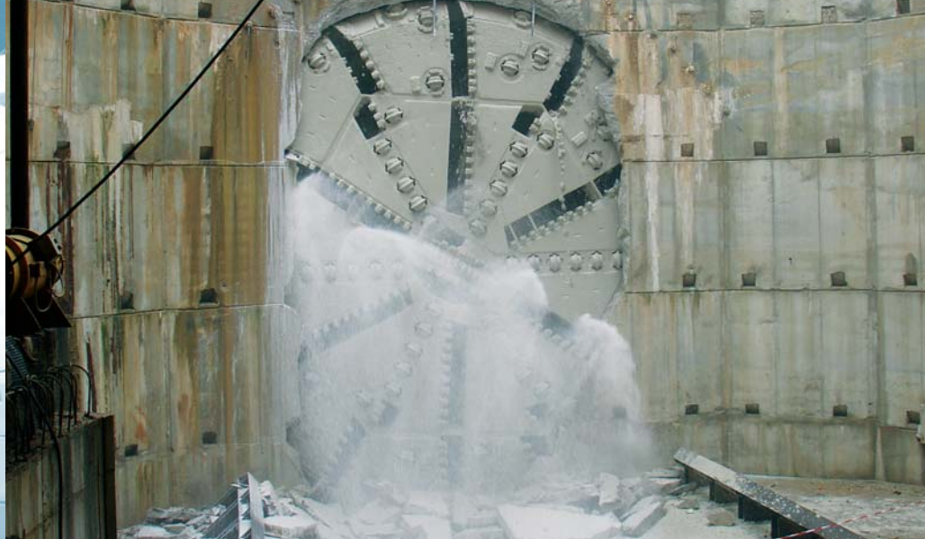
Tuneladora de la Línea 9 del Metro de Barcelona
