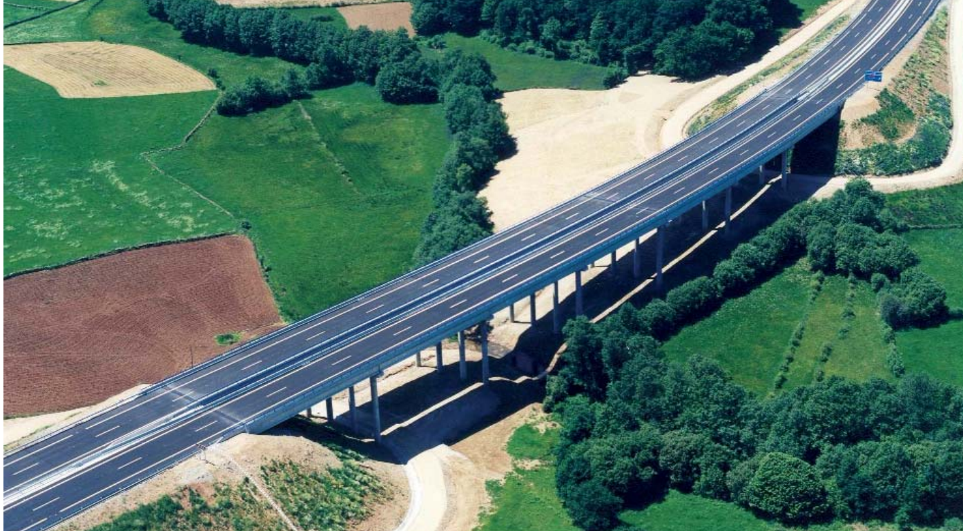
Autopista Santiago de Compostela-Alto de Santo Domingo. Galicia
