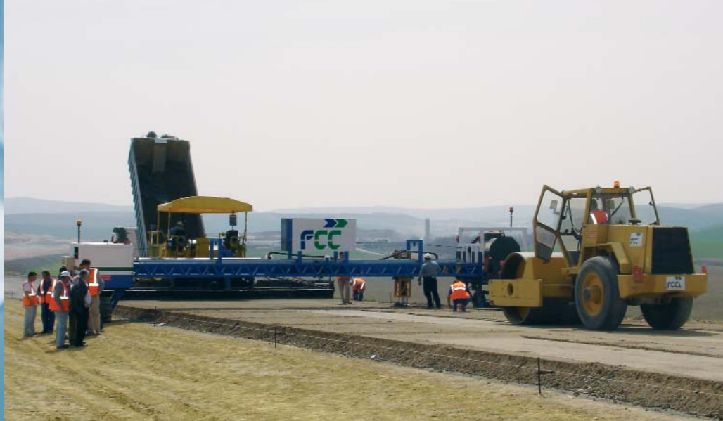
Premio Fomento a la Innovación. Diseño y fabricación de máquina para el prefisurado de suelo-cemento
