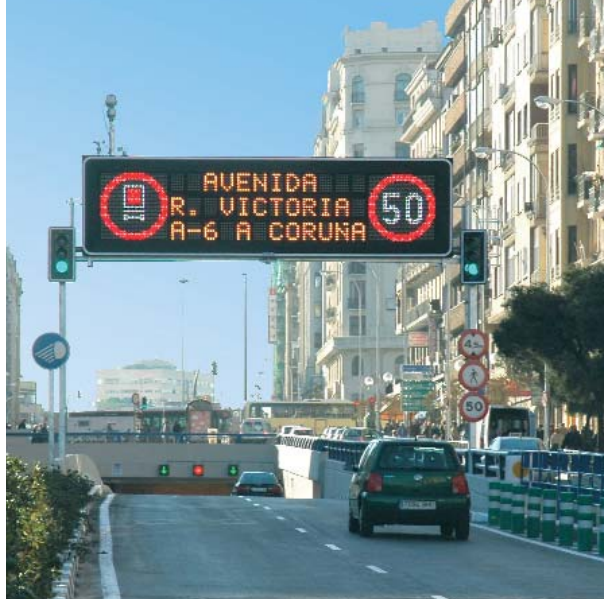
Sistema de control de tráfico del túnel de Cuatro Caminos. Madrid
