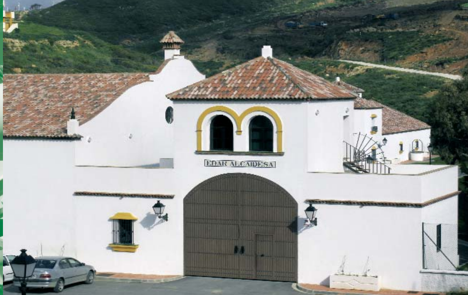
Estación depuradora de aguas residuales La Alcaidesa. Cádiz
